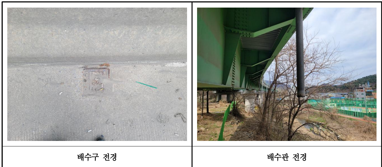
【사진 1.3.21】 배수시설 전경
