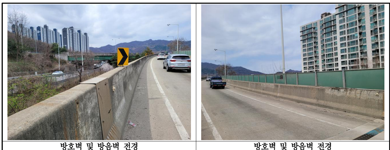
【사진 1.3.23】 방호벽 전경
