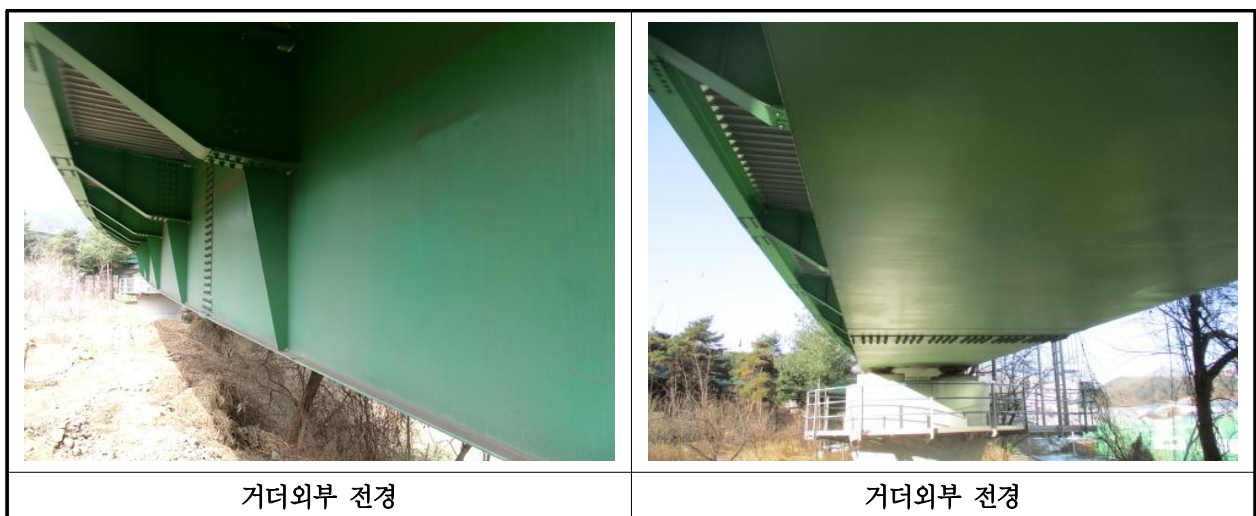
【사진 1.3.4】 거더외부 전경
