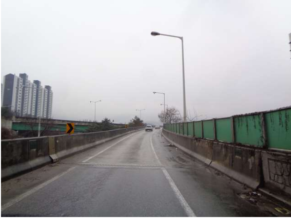
교량 상부 전경
