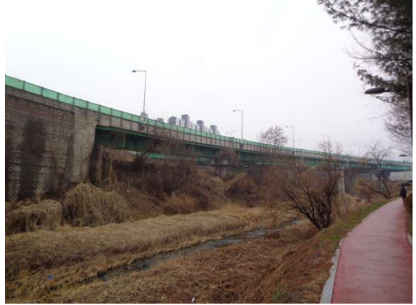
교량 측면 전경
