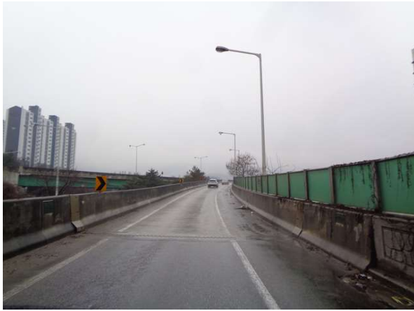
교량 상부 전경
