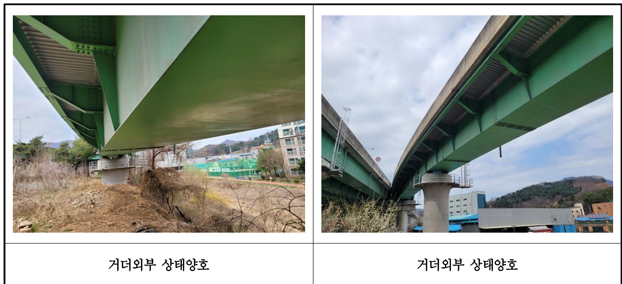
【사진 1.3.5】 거터외부 손상현황
