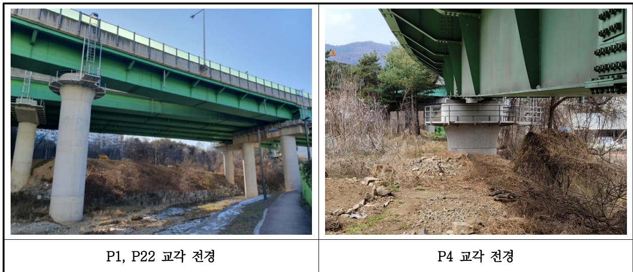
【사진 1.3.12】 교각 전경
