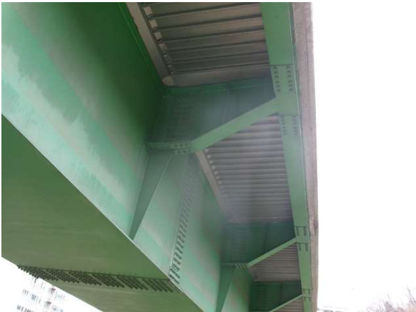
바닥판 하면 및 거더 전경
